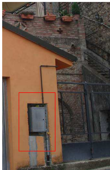
Tratti di tubazione di adduzione delle utenze installate a vista sulla facciata
